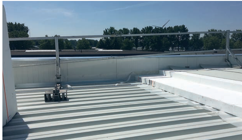
Aanbrengen van de BioFoam-isolatieplaten in twee lagen, met verspringende naden.
