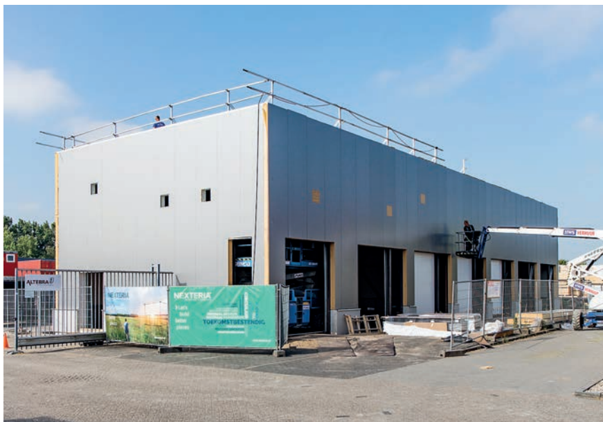
Volledig circulair bedrijfsverzamelgebouw in aanbouw in Deventer.
