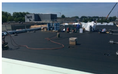
Op de isolatie komt de Universal POCB-dakbedekking van fabrikant Icopal.
