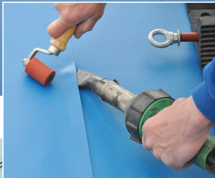
Alle dakbanen worden handmatig gelast.
