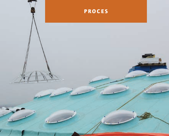
De bovenste ring in de uitvoeringsfase.
