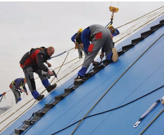
De MWR-isolatie bij de overgang van een stramien.
