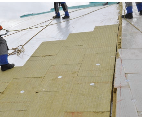
De MWR-isolatie bij de overgang van een stramien.
